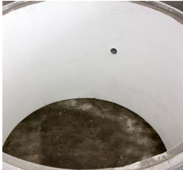
FIG. 13 2300 Diameter Manhole Riser
